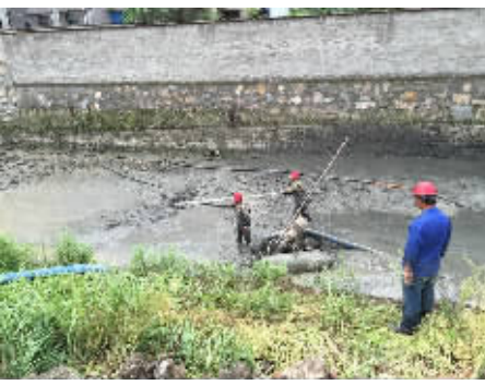
沿山港清淤整治中
