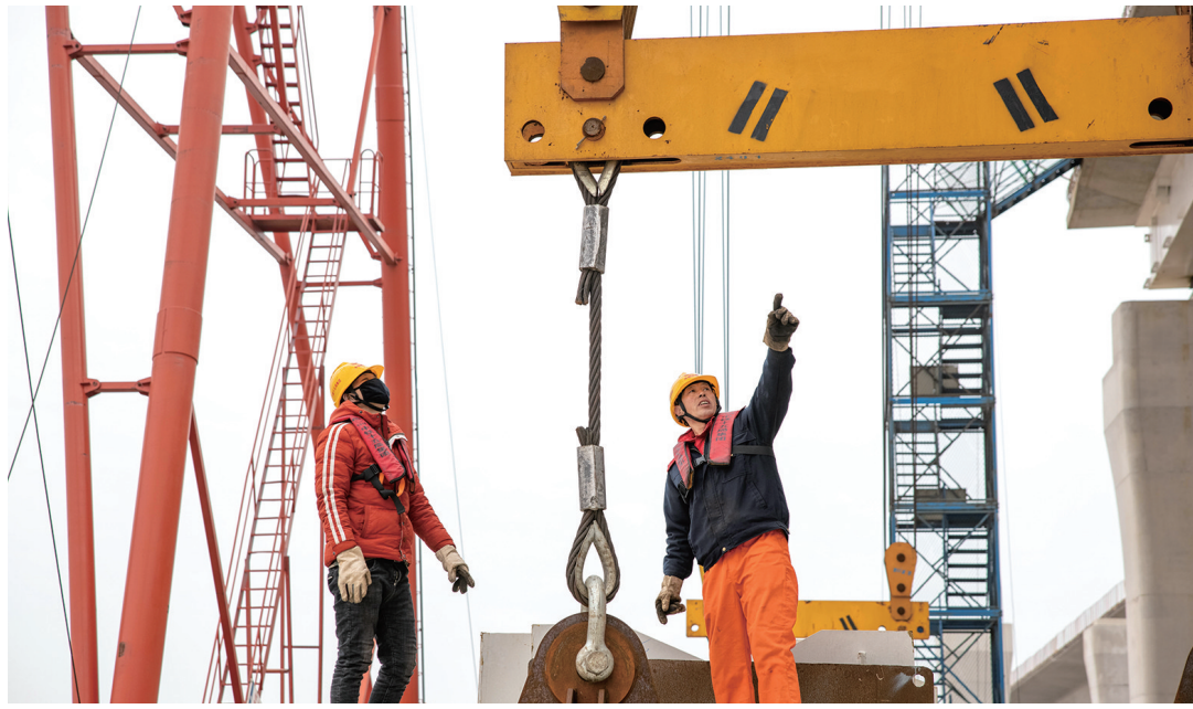
工人们在杭甬高速复线一期工程现场工作
