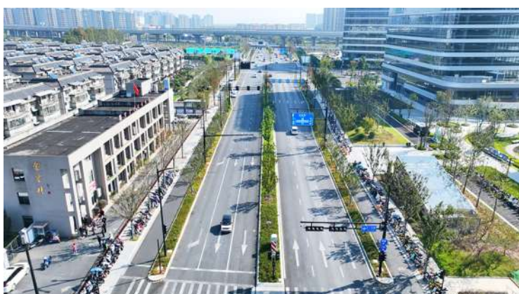
文二西路西延工程
