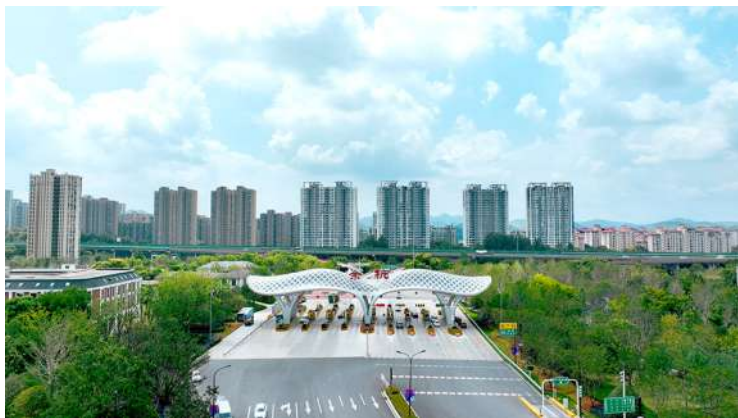
杭徽高速余杭收费站
