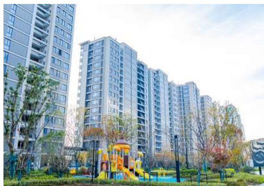
杭州西站枢纽H-R21-10地块安置房项目
