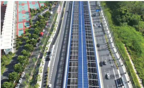
余杭东西向快速路光伏项目
