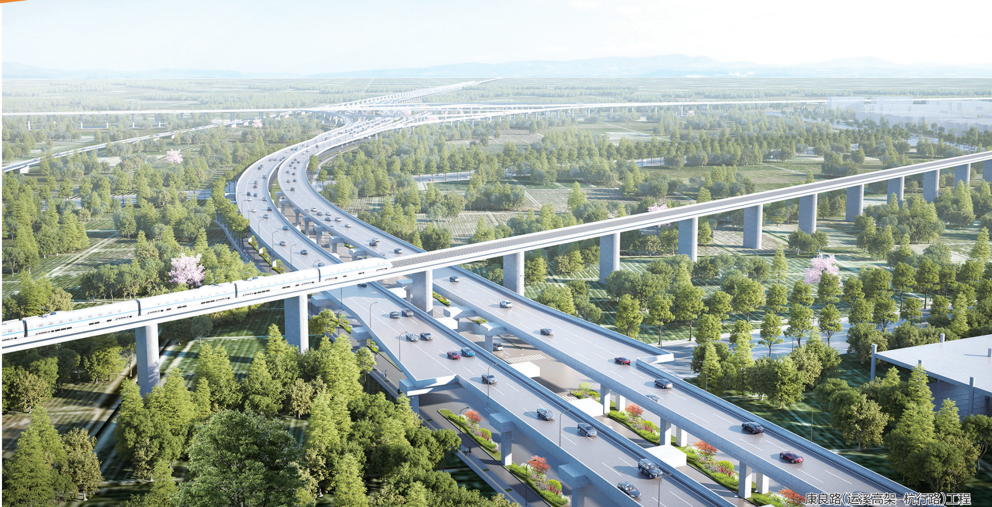
康良路(远贤高架-杭行路)工程
