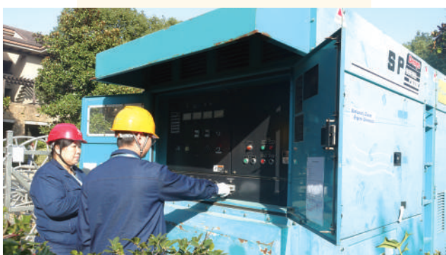
供电员工为“良渚论坛”举办地加装UPS电源等设施
