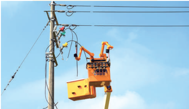
带电作业机器人进行带电搭接
