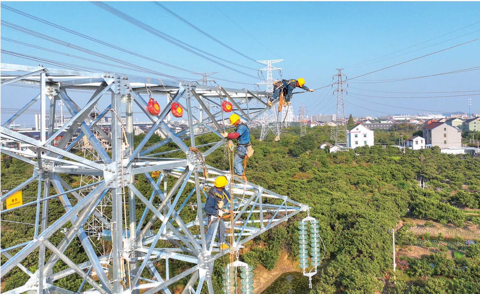
供电员工对南湖区块涉及的110千伏输电线路开展送出专线迁改工作
