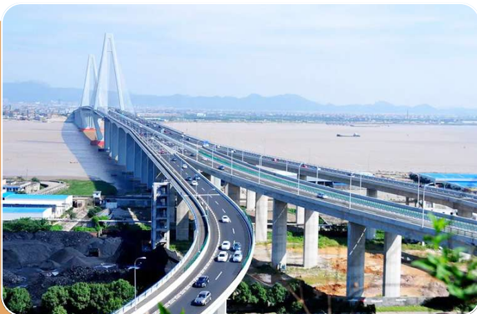
74省道南延三门毛张至椒江二桥三门段工程
