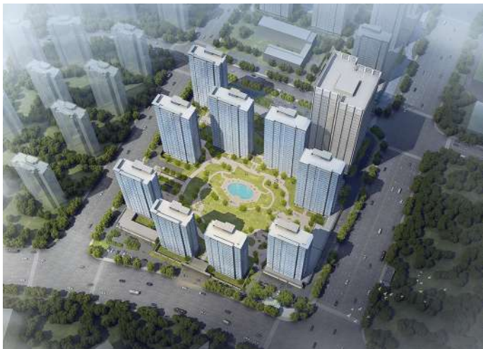
杭政储出(2022)46号地块二标段项目
