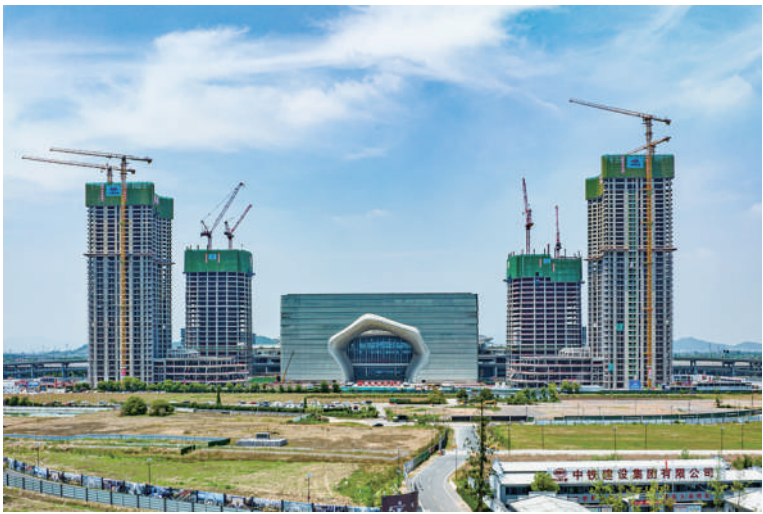
云门两侧是正在施工的金手指综合体
