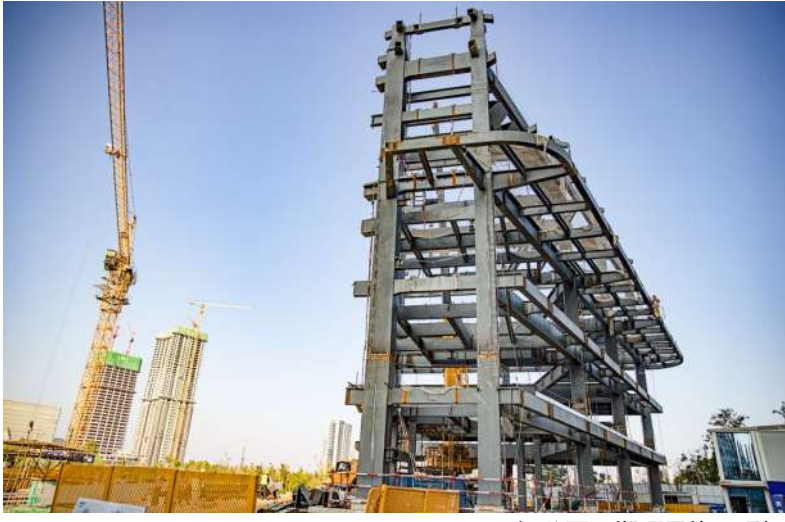
云门公园一期项目施工现场
