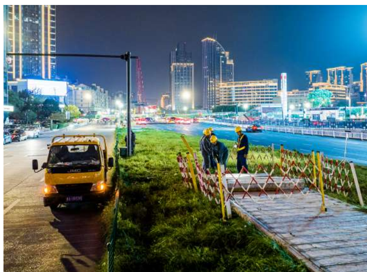
地铁3号线供电线路迁改作业
