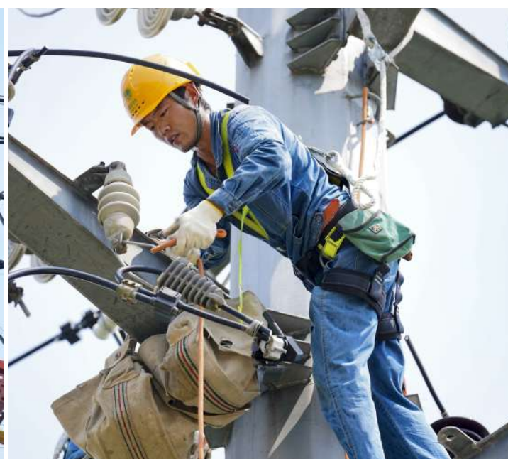
西险大塘线路迁改作业
