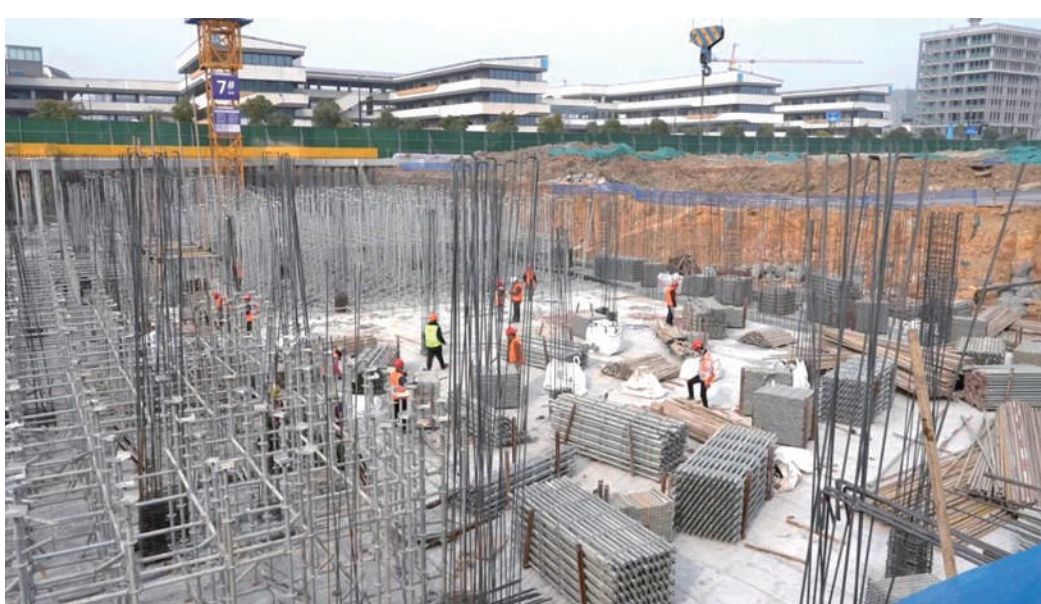
瓶窑镇D12地块保障性住房项目施工现场
