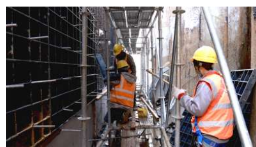
工人们正在城西南排工程南段顾家桥港施工
