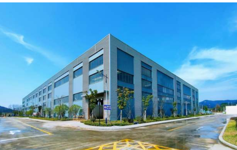
建筑垃圾资源化利用项目一期
