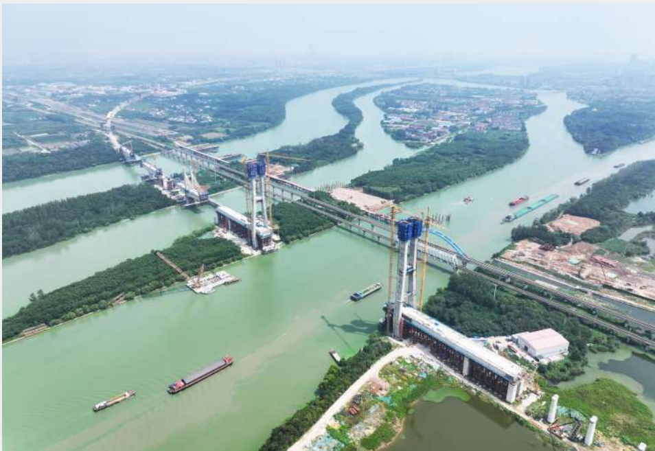
沪渝蓉高铁跨京杭运河斜拉桥建设现场
