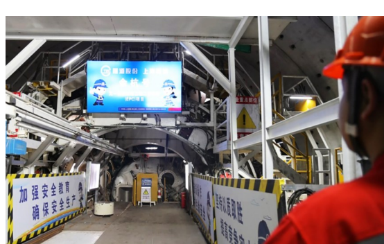
文一西路西延(二期)建设现场
