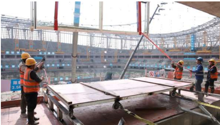
余杭国际体育中心建设现场
