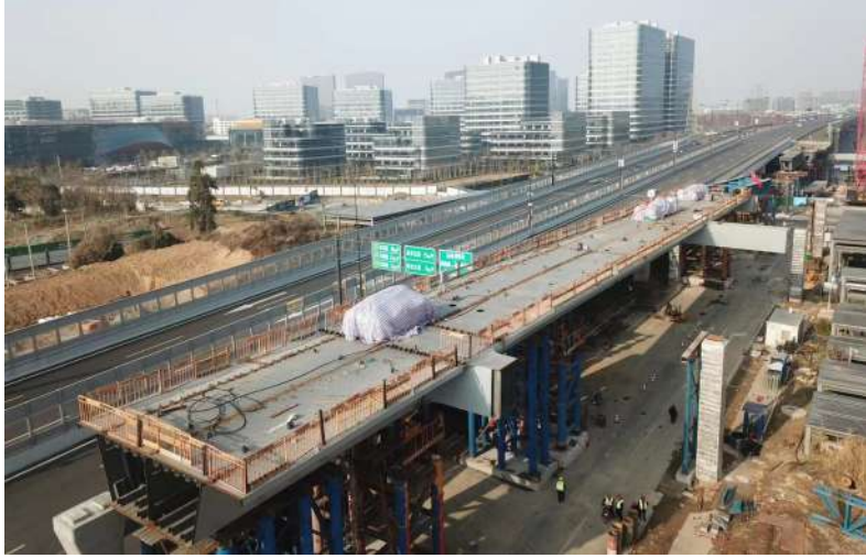
这是两张杭徽高速余杭互通接线改建工程D匝道施工现场图，左图拍摄于去年12月31日，右图拍摄于1月3日。以高架上的绿色路牌为参照物，可以明显发现钢箱梁整体向图片右上角方向移动了。
