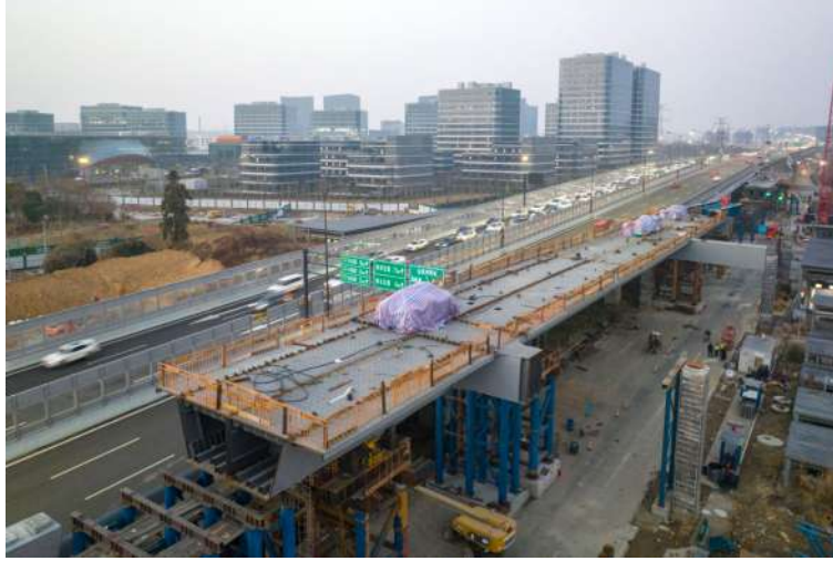
这是两张杭徽高速余杭互通接线改建工程D匝道施工现场图，左图拍摄于去年12月31日，右图拍摄于1月3日。以高架上的绿色路牌为参照物，可以明显发现钢箱梁整体向图片右上角方向移动了。
