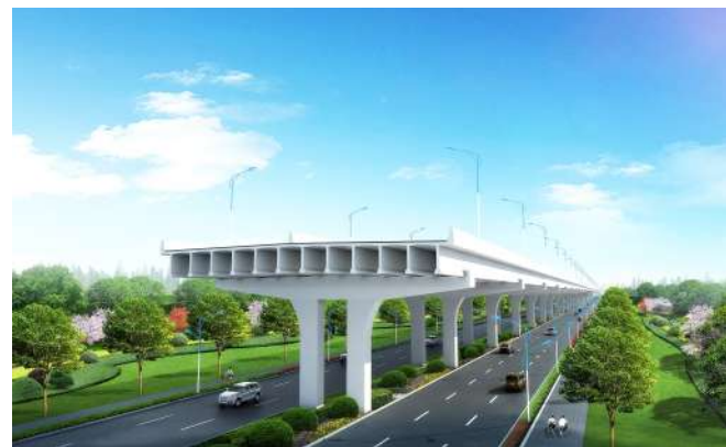
104国道杭州至绍兴公路(余杭良渚至崇贤段)改建工程第TJ01标段
