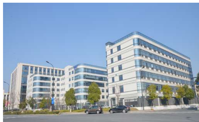
普晶电子办公大楼实景
