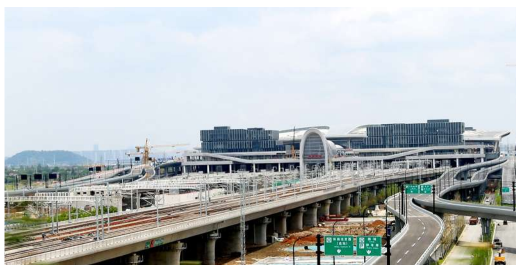
杭州西站枢纽工程
