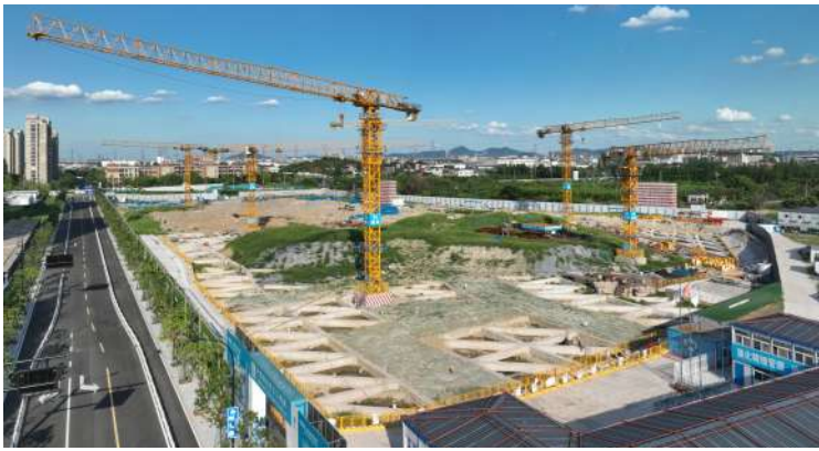
树东路以南公租房项目建设现场
