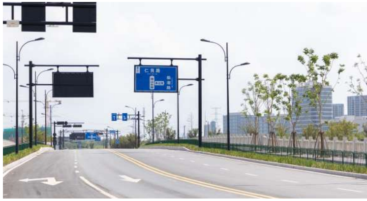
獐山路西延(奉运路-仁康路)道路
