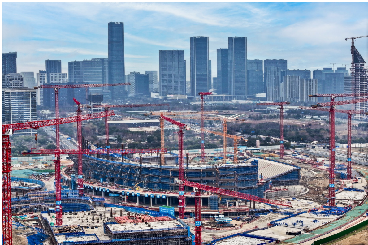
余杭国际体育中心施工现场
