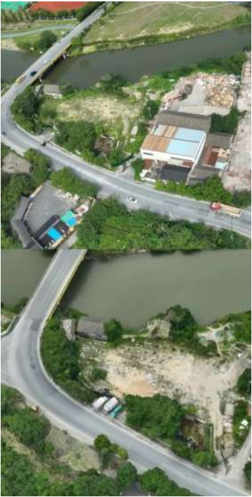
上方为无人机倾斜摄影,下方为三维建模软件出图
