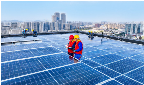
▲ 检查企业屋顶光伏资源利用情况
