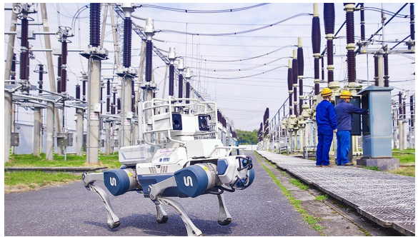
▲ 用“机巡+人巡+空巡”模式检查220千伏大陆变电站主变设备
