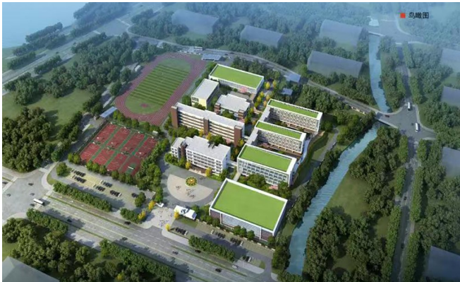
余杭区太炎中学城南校区项目
